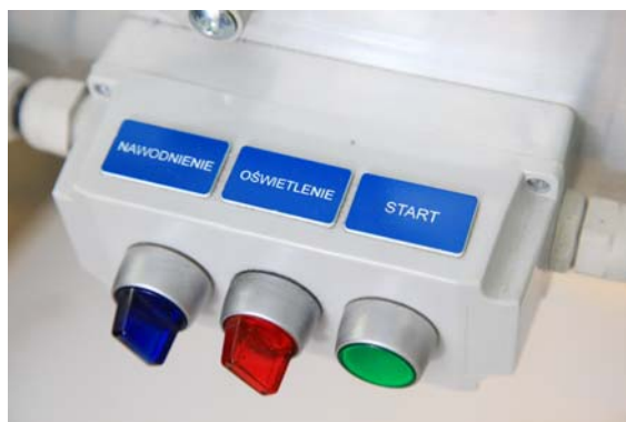
Kaseta sterownicza przycisku startowego, oświetlenia i nawadniania
