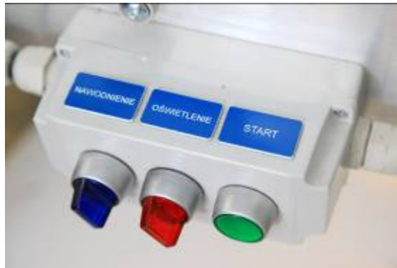
Касета управління кнопки пуску, освітлення та зрошення
