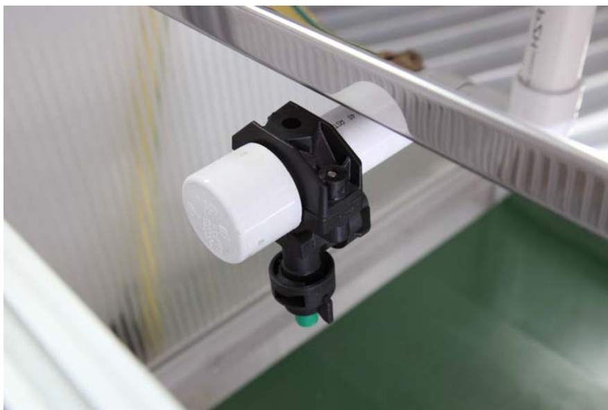
Zraszacz z antykapaczem zamontowanym na korpusie zraszacza Dozowanie wody reguluje się poprzez wymianę dysz zraszających.
